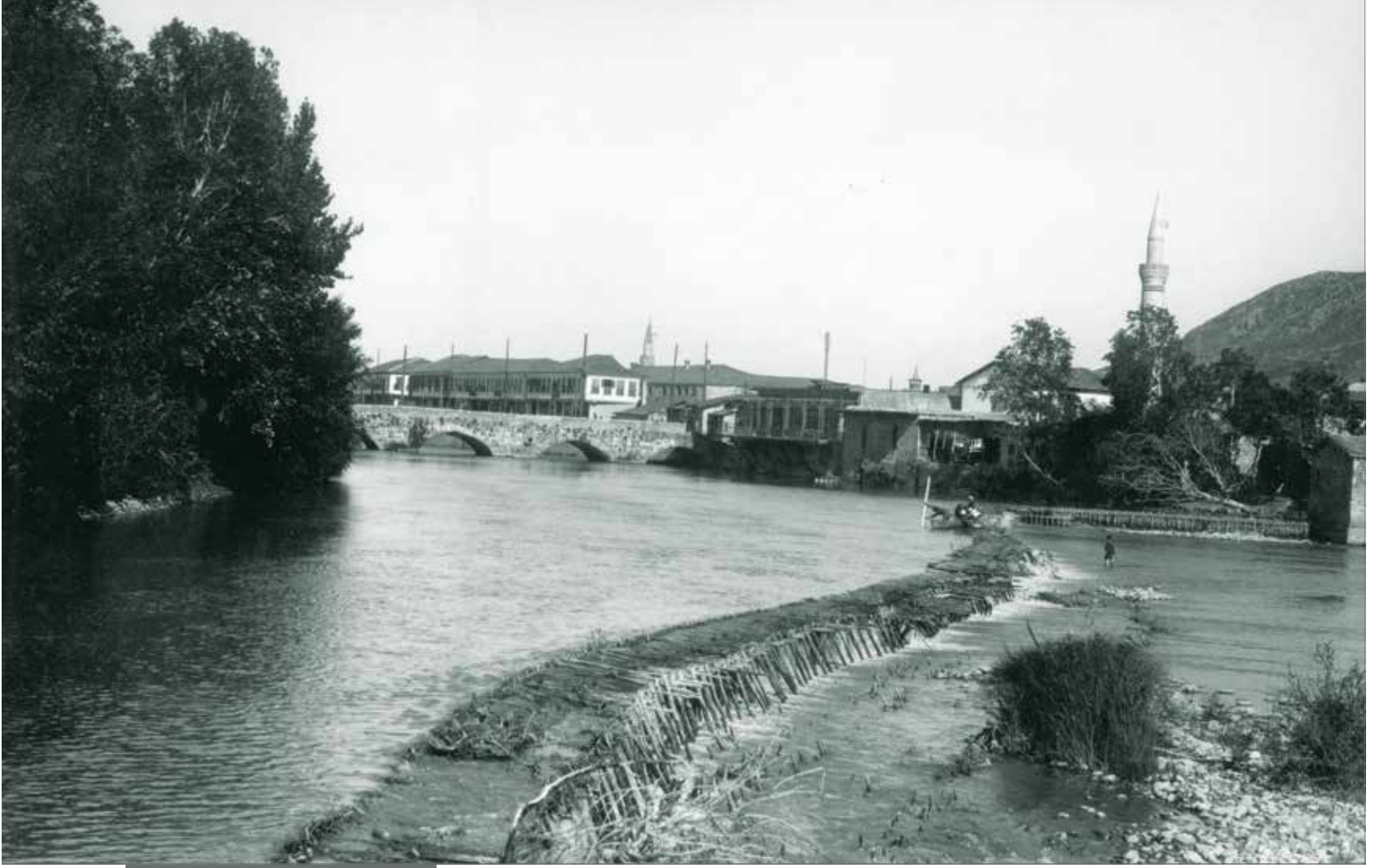
Harbiye tarafından Asi Nehri ve Antakya Köprüsü görüntüsü.
