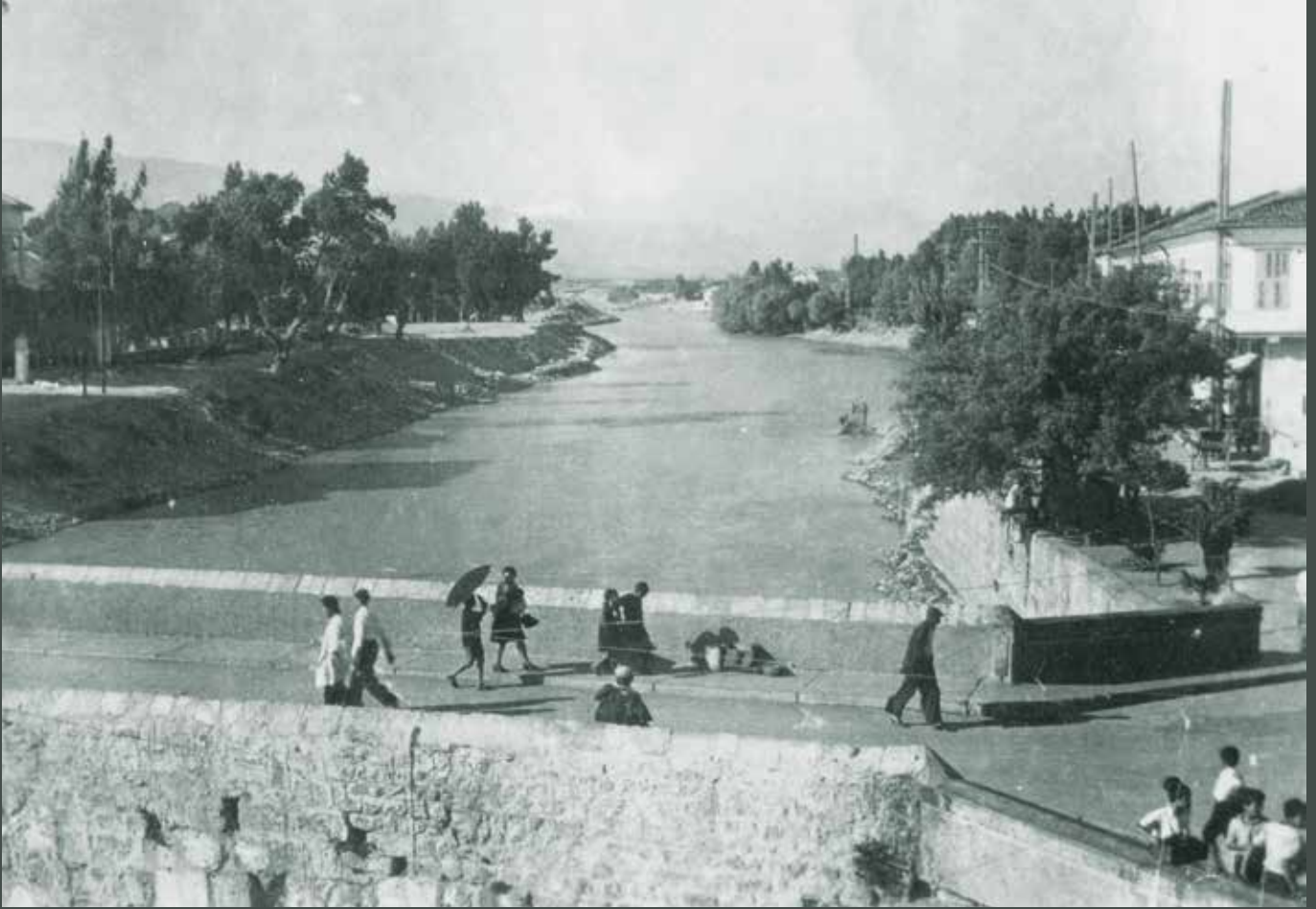
1940'lı yıllar... Köprü henüz tamir görmemiş. Köprü'nün kenarları kalın taş duvarlardan yapılmış. Kenar duvarların üst yüzeyi sivri şekilde örülmüş ve sıvanmış. Muhtemelen bu şekilde zaman içinde yapılan tadilatlardan biri. (Bkz. Şaul Cenuodioğlu rapörta)
