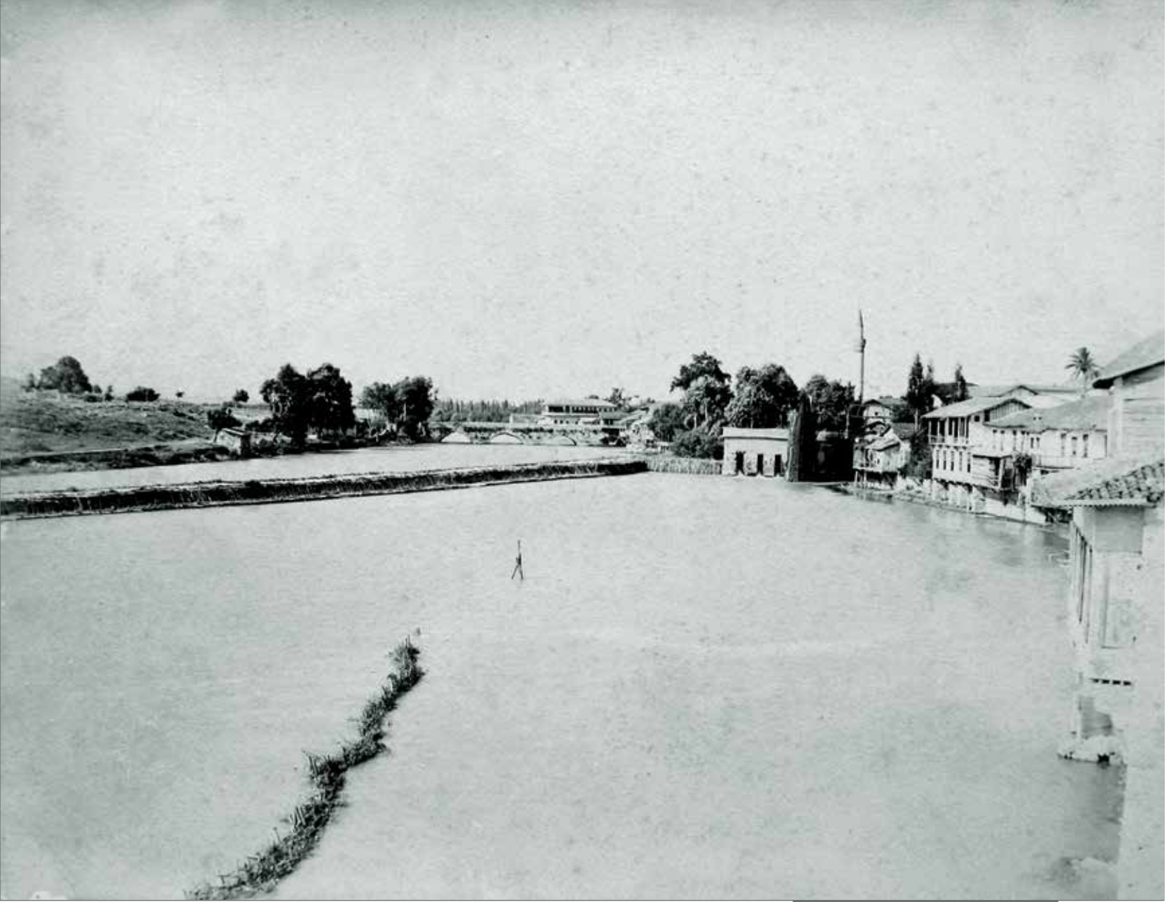
Asi Nehri ve Antakya Köprüsü. 75 Asi Nehri'nin şehir içinde en çok genişlediği yer (bu bölüm daha sonra doldurulmuştur). Saz ve kamışlardan yapılmış bentler, nehir kenarındaki evler, su dolabı, Ulu Cami ve uzaklarda tarihî Antakya Köprüsü.
