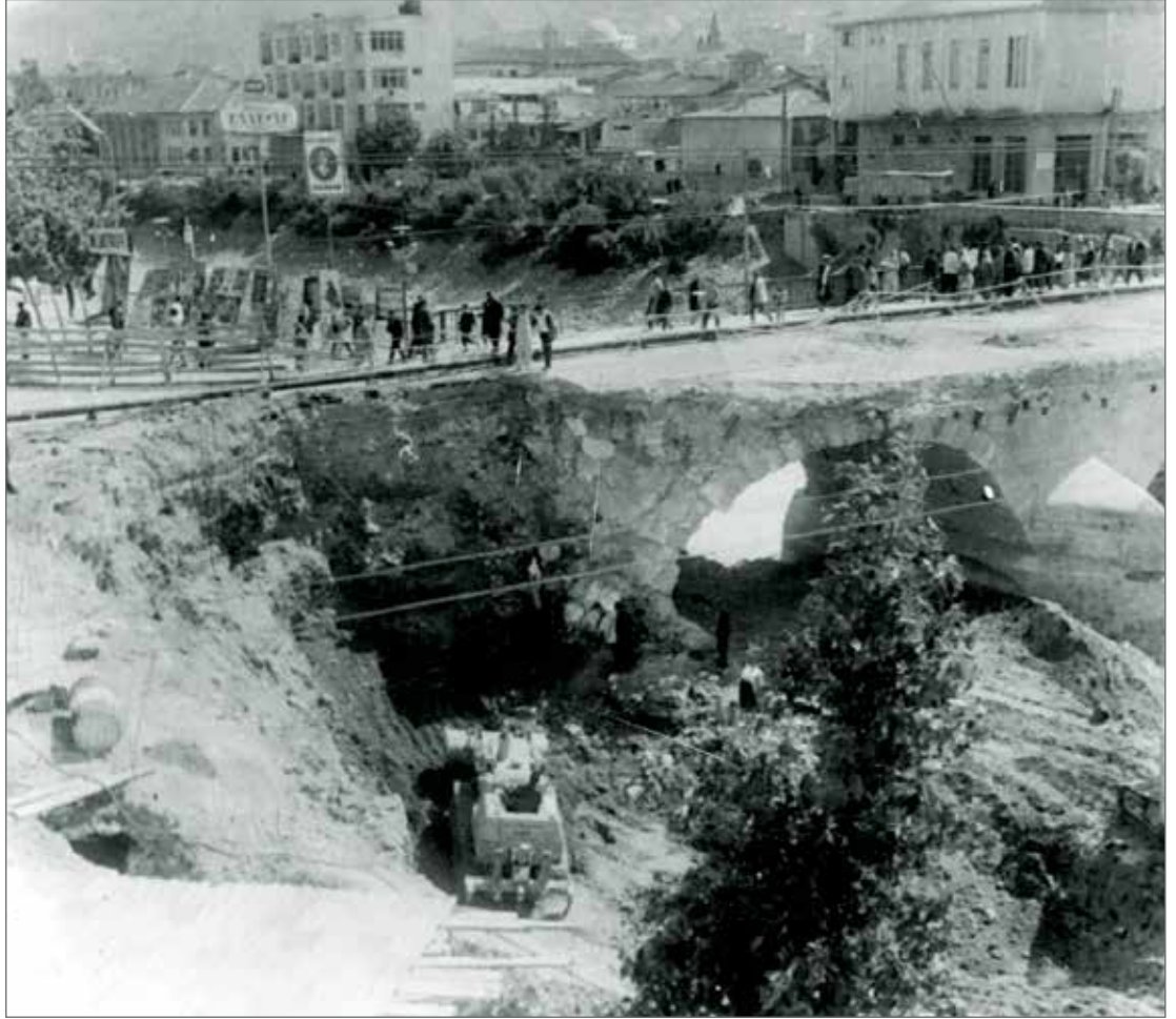
Köprü yıkımı esnasında geçici yaya köprüsünden iki yaka arasında ulaşım sağlanıyor.
